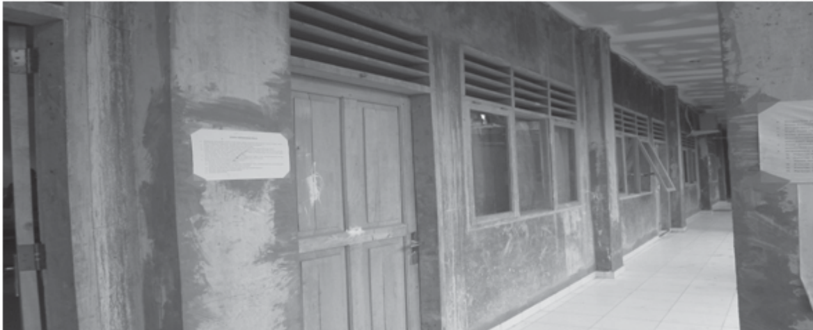
Sumber : Dokumentasi Penulis (2014)
